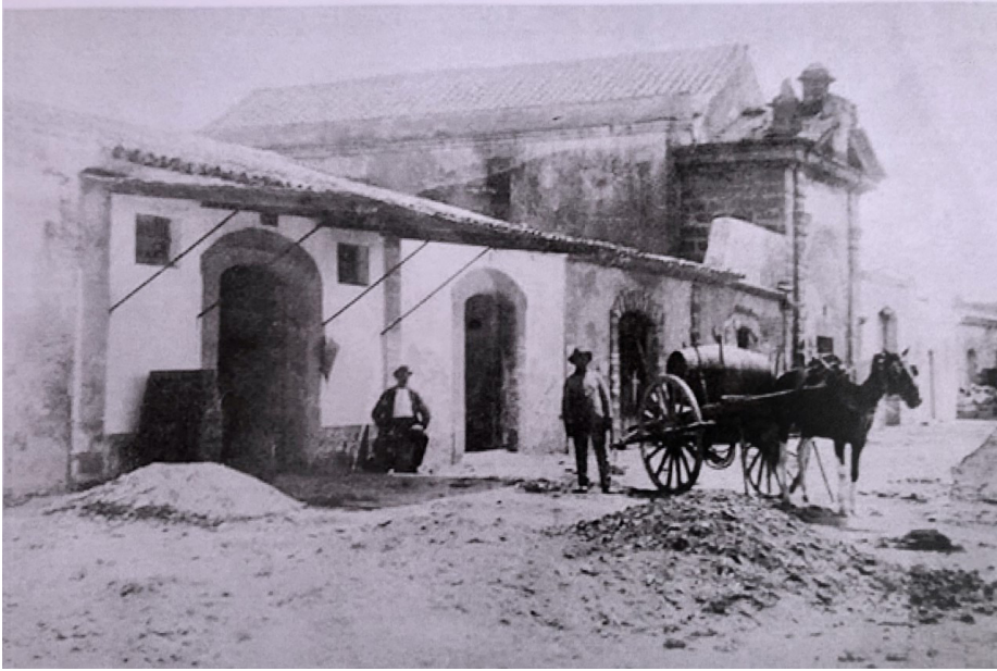
Vista de las naves del Real Carenero, ocupadas por los almacenes de la Fábrica de Aguardiente La Esperanza de San Fernando. Principio del S. XX. Foto archivo familiar de D. Alejandro Zambrano Sevillano.
