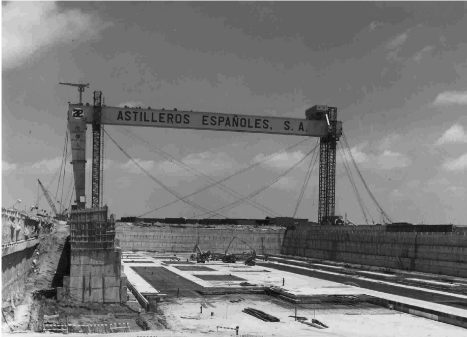
Figura 0-0. Vista general del nuevo dique seco en fase de construcción. Fuente: Museo “El Dique”
